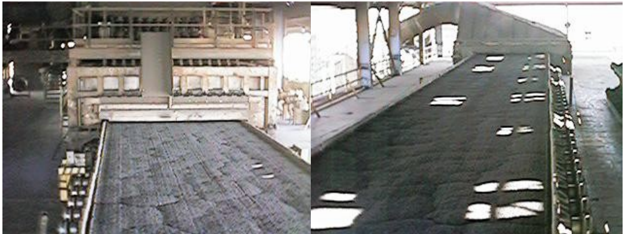
Fig.1 – Fotos da Máquina, onde vemos as caixas de Sinter (setores) em trabalho.
